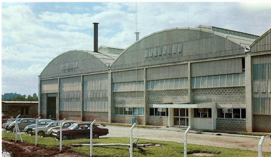
São Paulo. De to nye fabrikshaller. Fabrikken er beliggende på en grund på i alt 26.000 m 2 , hvoraf 8.500 m 2 er bebygget.
