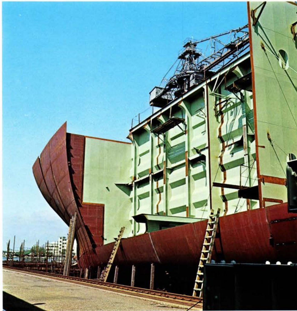
Nakskov. Forbehandlede lasttanke i en 26.000 tons dødvægt products carrier.
