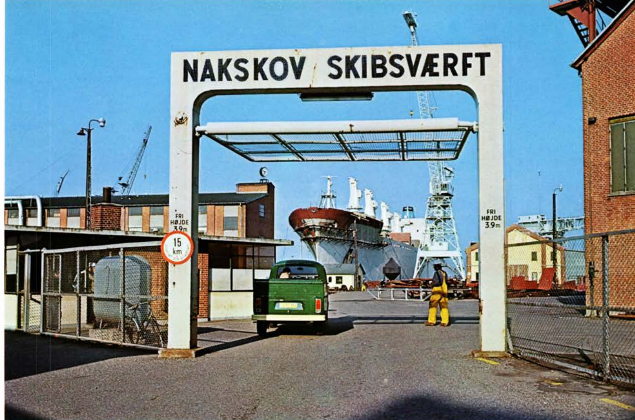
Nakskov. Hovedindgang til værftsanlægget med et semi-containerskib under udrustning i baggrunden.
