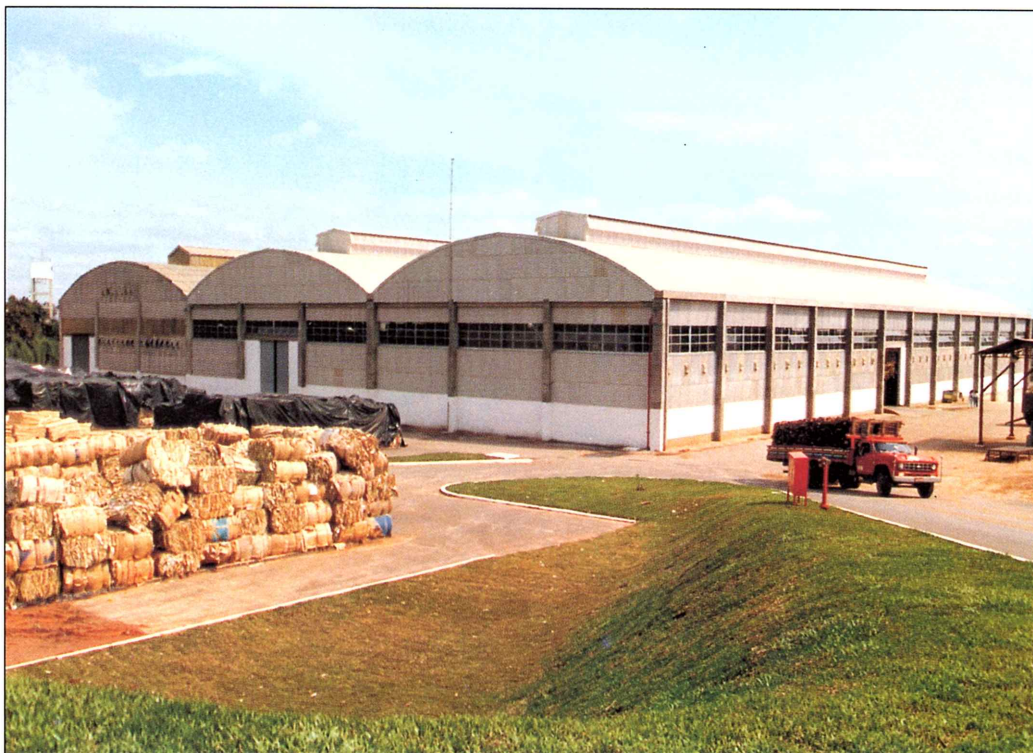
De to nye lagerhaller, der er opført i umiddelbar tilknytning til den eksisterende lagerbygning.
