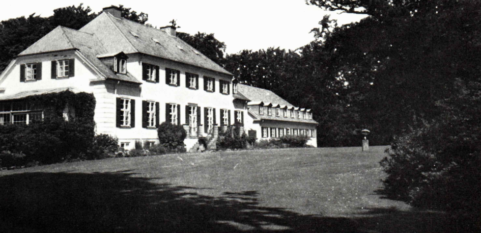
Kursusejendommen »Rolighed«, Skodsborg. The tuition centre "Rolighed", Skodsborg.
