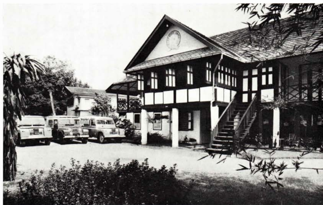
Lampang. Den tidligere filialbestyrerbolig. Lampang. The former "Manager's Bungalow".
