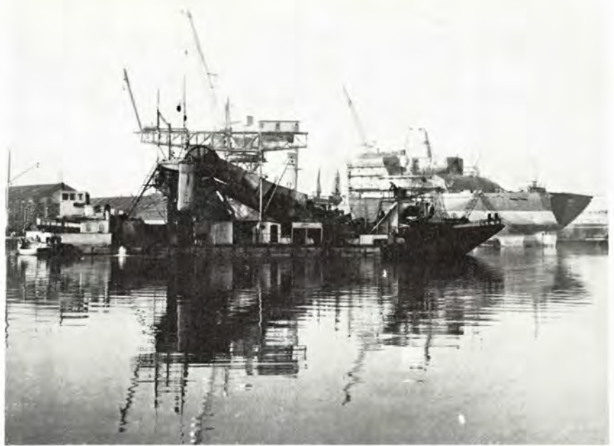
Nakskov. En tysk gravemaskine i aktion uden for beddingsområdet på Nakskov Skibsværft. Nakskov. A German dredger at work outside the slipway area of Nakskov Shipyard.
