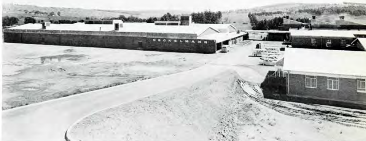
Hammarsdale. Udsigt over fabriksbygningerne, set fra hovedindgangen.
