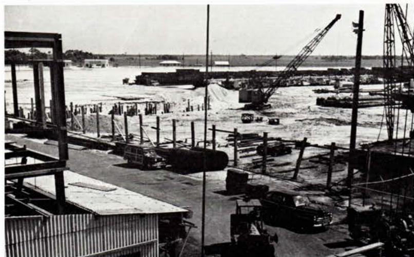
Et almindeligt skue i Liberia i dag. Der bygges huse og veje, og nye havne anlægges.
