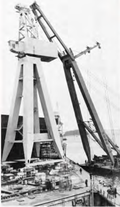
Nakskov Skibsværfts nye 100-tonns beddingkran blev i weekend'en 27. og 28. marts bragt på plads af 400 tons-flydekransen "Hebe".
