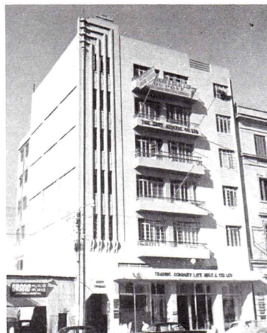
Karachi. Kompagniets centralt beliggende kontorer i »Adamjee Chambers« på McLeod Road.
