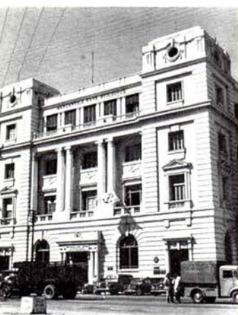
Til venstre: Madras, Mercantile Bank Building, hvor Kompagniet optager 1ste etage.
