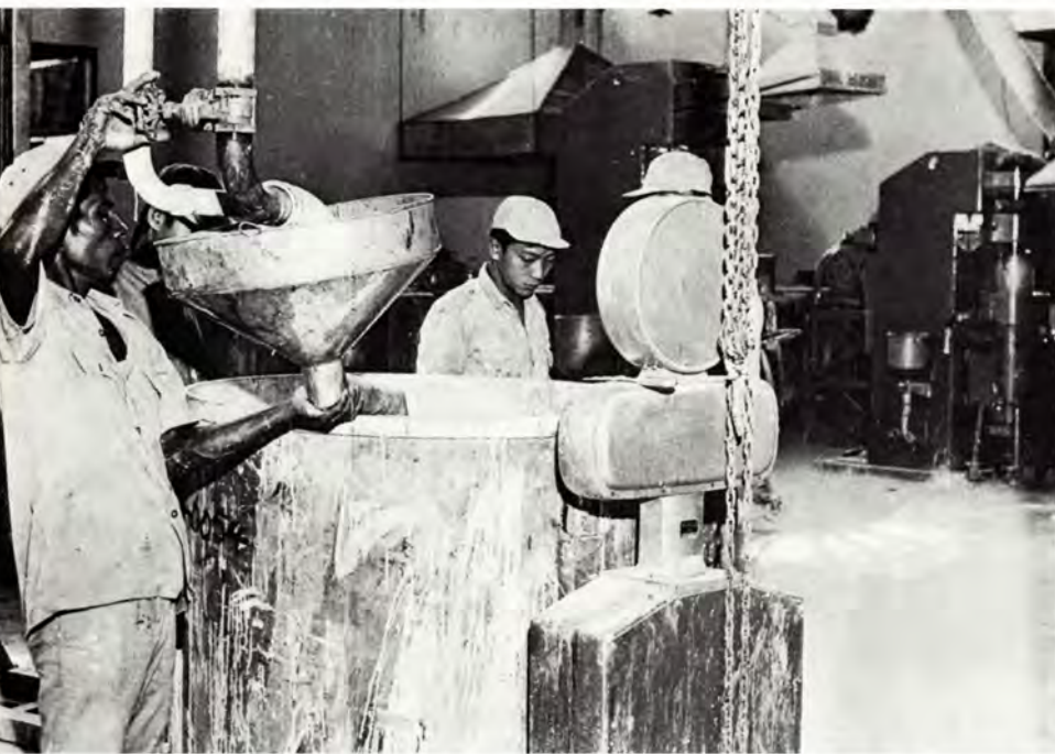
Pulo Gadung. Tilførsel af råmaterialer til en fabrikation maling. Beholderen står på en Divus vægt. Pulo Gadung. Raw materials being added to a batch of paint in a container placed on a Divus scale.
