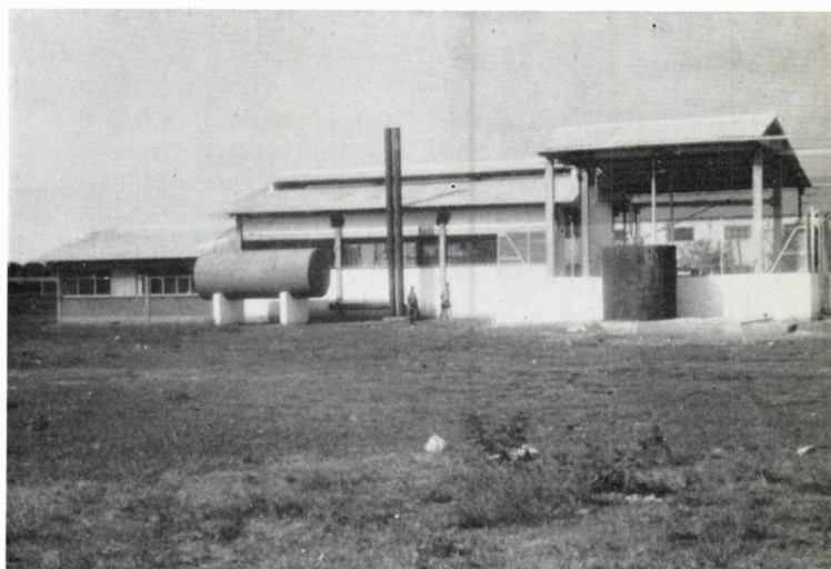
Bera-fabrikken i Cali, Colombia.
