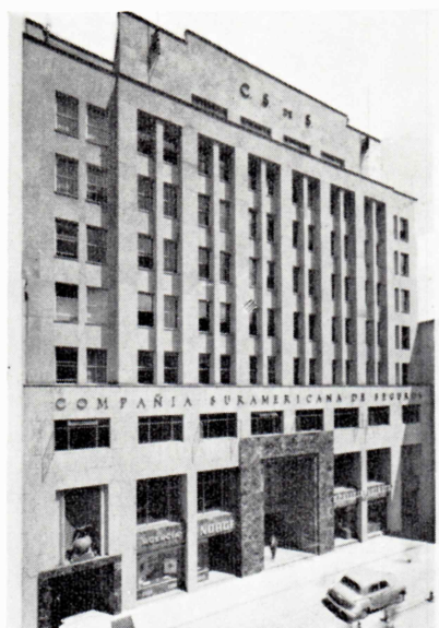
Medellin kontoret har lokaler i en moderne centralt beliggende bygning, tilhørende det store forsikringsselskab Suramericana de Seguros. The Medellín office is centrally situated in the modern building of Suramericana de Seguros, a big insurance company.
