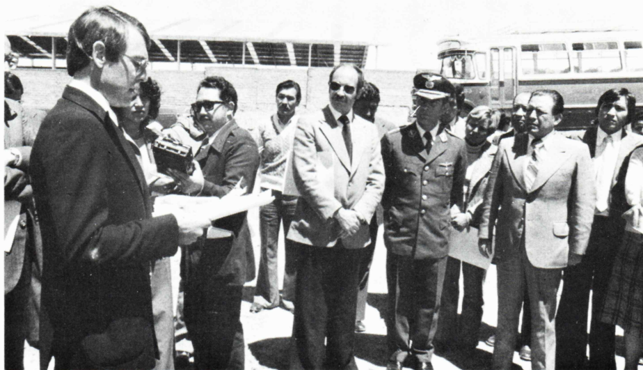
Direktør Poul Skytte Madsen byder gæsterne velkommen til grundstensnedlæggelsen. I forgrunden brigadegeneral E. C. Hurtado, flankeret af generalmajor H. O. Mattos (t.h.) og ingeniør J. L. Patiño, teknisk direktør for ENAF.
