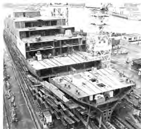
Nybygning nummer 224 . Newbuilding number 224
