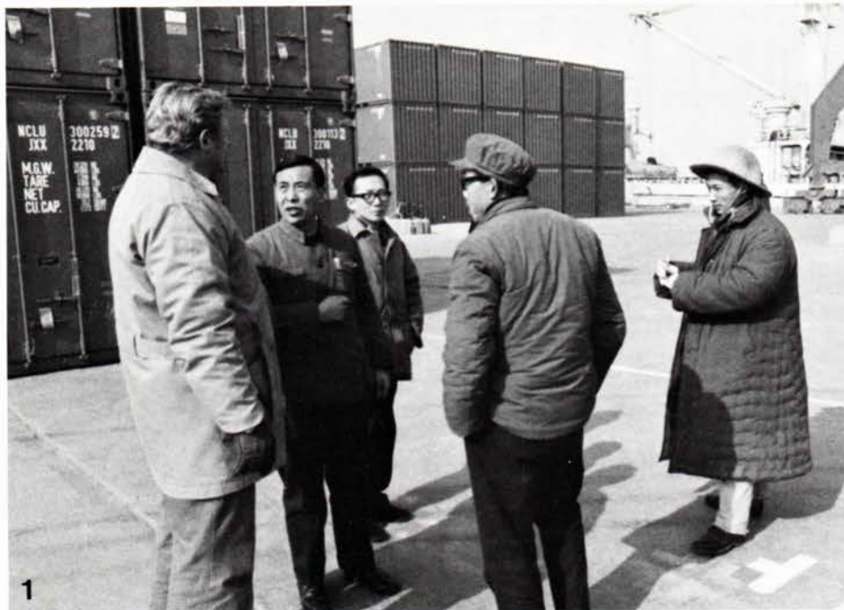
1 Planlægning af Shanghai's container terminal diskuteres på stedet.
