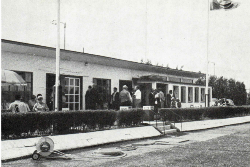
Her ses idrætsanlægget Tre Kronor's omklædningsrum og restaurant. Man nyder en forfriskning i pausen.
