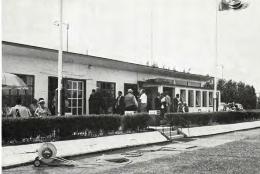
Her ses idrætsanlægget Tre Kronor's omklædningsrum og restaurant. Man nyder en forfriskning i pausen.
