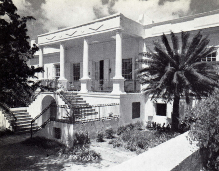
St. Thomas. Filialbestyrerens bolig »Denmark Hill«.
