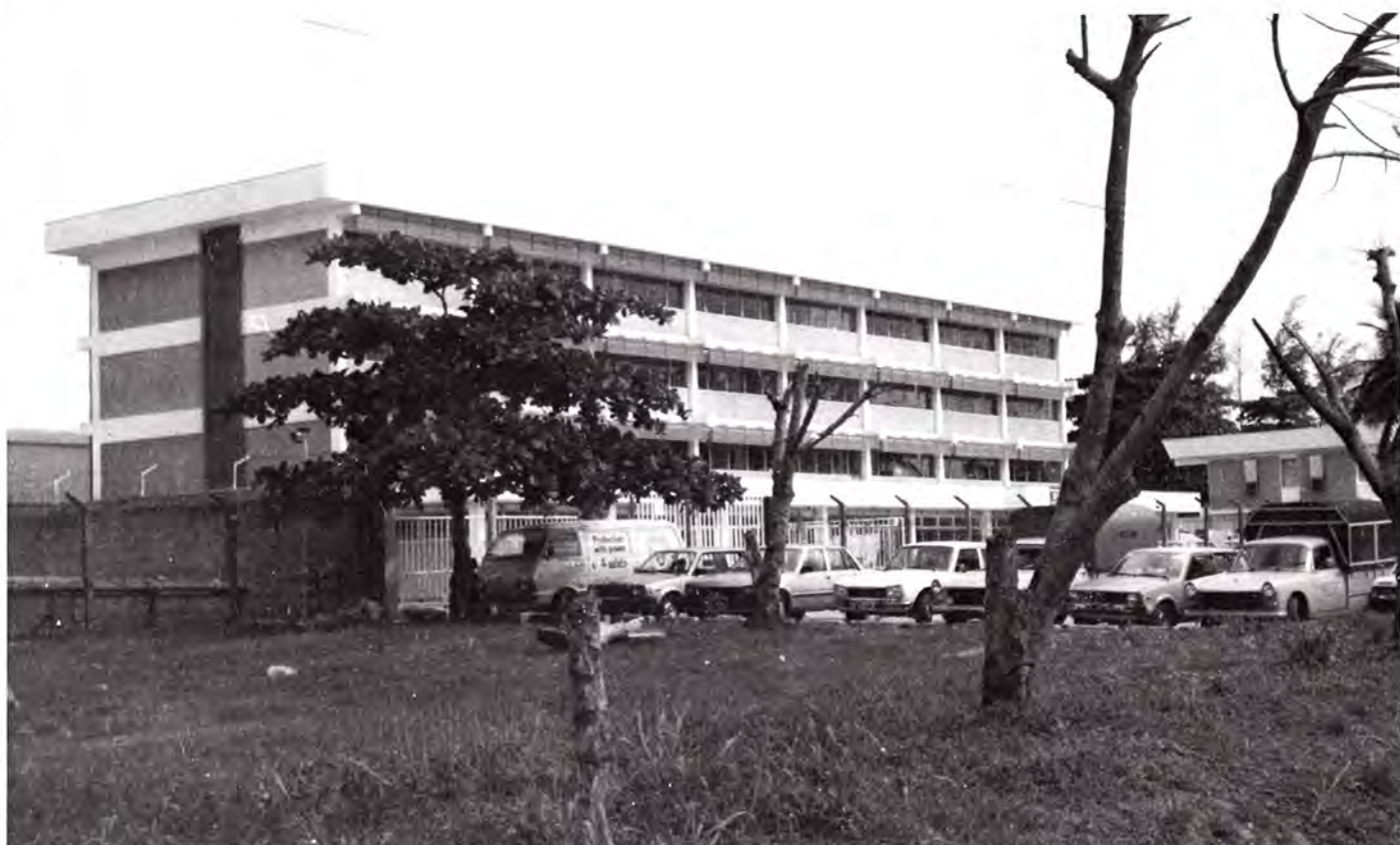
Den nye kontorbygning i Matori. New office building at Matori.
