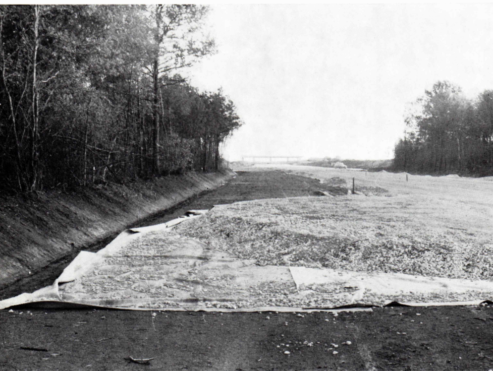
Fibertex som motorvejsfundament.
