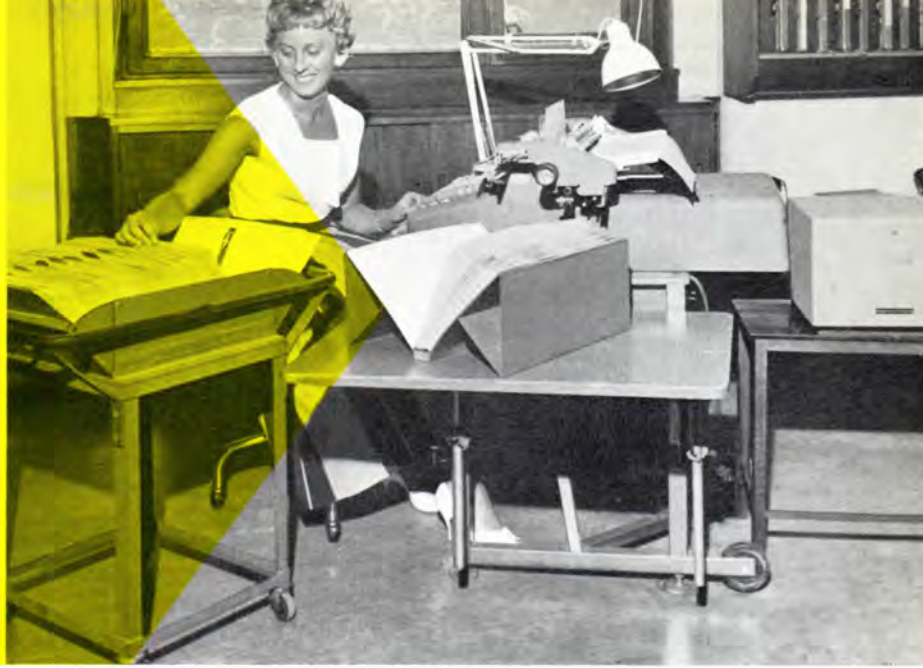
Fru Lise Christensen med sin tekstskrivende bogholderimaskine Cl 3100. Til venstre »vogn« med kontokort, derefter en kassette med kontokort og endelig det lukkede hulbånds-aggregat. På væggen et skab med udskiftelige funktionsstænger, der på få sekunder omstiller maskinen fra et arbejde til et andet.
