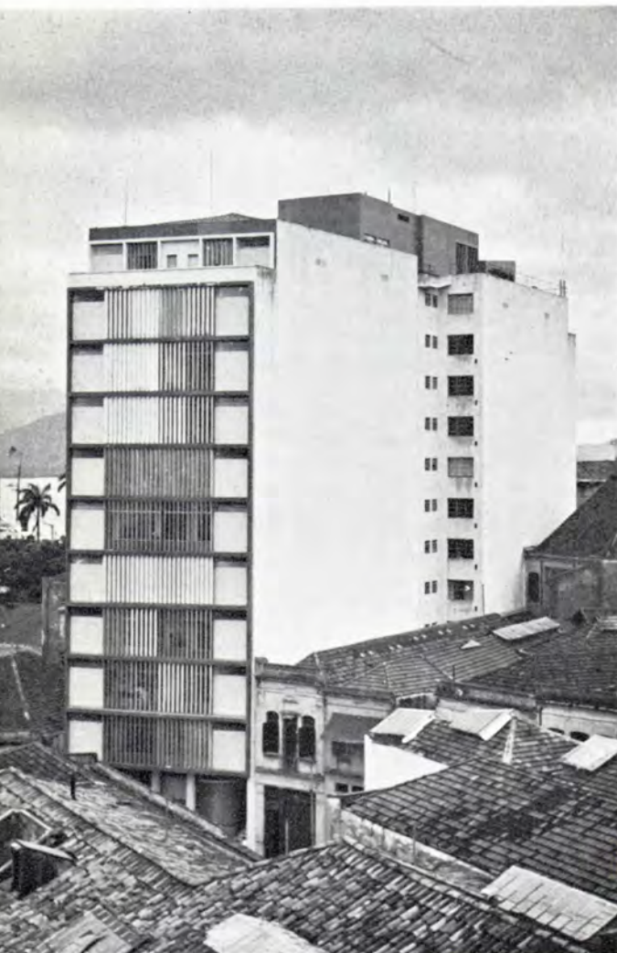
Santos. Bagsiden af kontorbygningen hvor O. K. kontorerne ligger på 6. sal. Bygningen ligger lige over for indgangen til Santos' kaffeboers. I baggrunden et udsnit af havnen.
