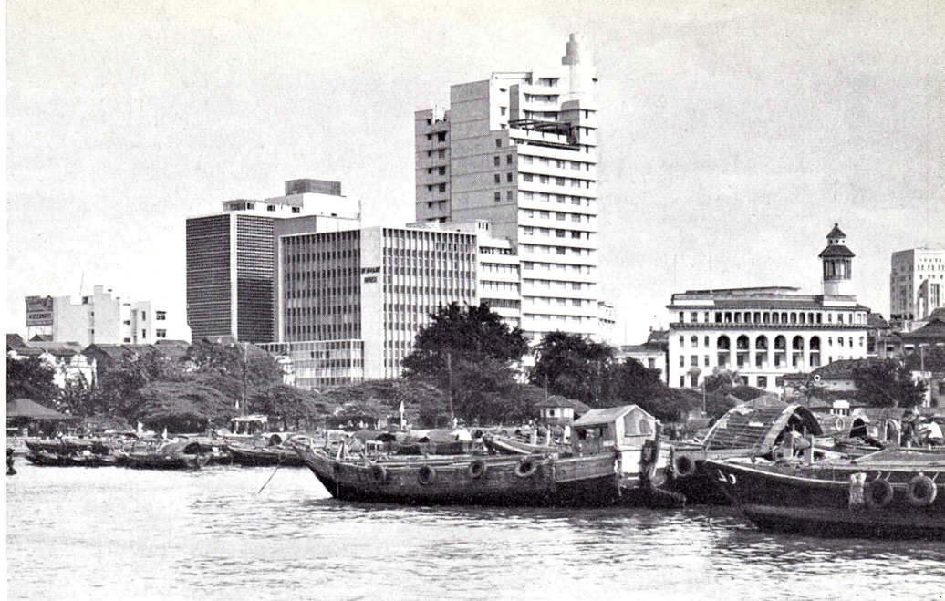
Singapore. Kompagniets nye kontorbygning med navnet »Denmark House« i store bogstaver.
