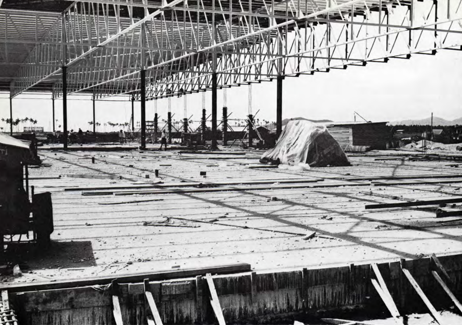
Penang. November 1972. Råvarelagerets stålkonstruktioner.
