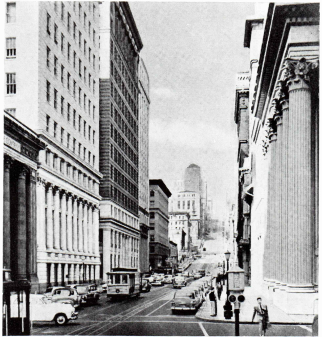
California Street er centrum for San Franciscos »shipping business«. Kontoret er i »Merchant Exchange Building«, (hvis nederste del på billedet dækkes af byens velkendte »cable car«).
