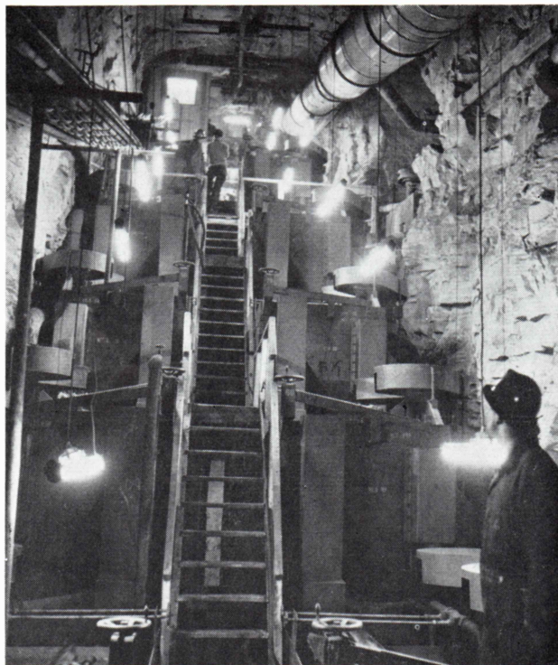
Store og komplicerede maskiner arbejder i Blyklippens indre.
