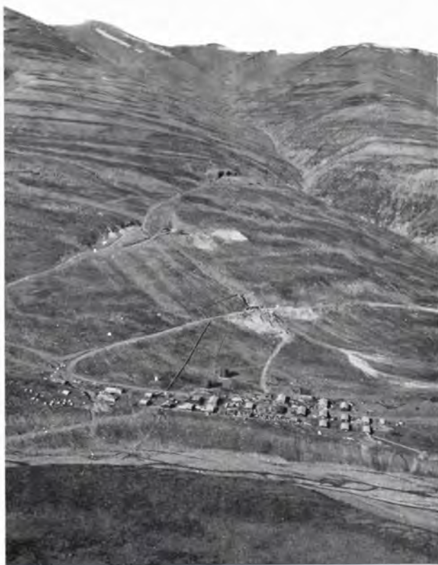
Blyklippen. I forgrunden Gefionelven. I midten af billedet tunnelindgang og lagerplads på 335 m niveau. Længere oppe indgangen på 415 m niveau og højere oppe dagbruddet på 485 m niveau.
