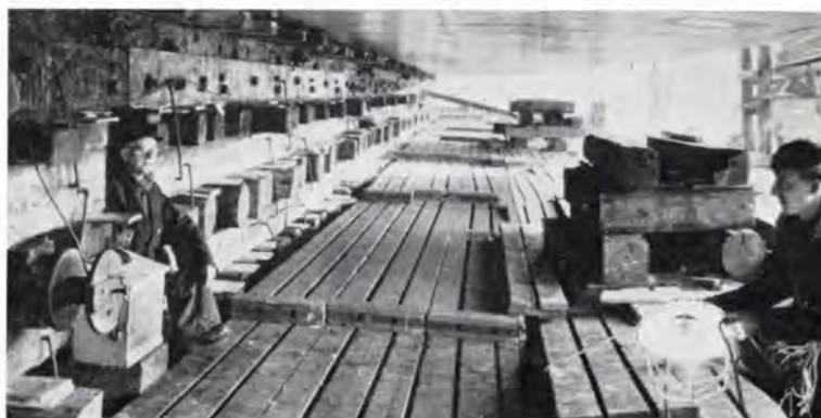
Lige før en stabelafløbning hos B. & W. Den flade skibsbund ligger som et loft over hovedet på arbejderne. Skroget hviler på »slæderne«, og i samme øjeblik skibets gudmoder knuser champagneflasken mod stævnen, ringer en lille klokke som signal til manden ved pumpe. Han åbner for olietrykventilen, palerne slipper, og skibet »skorer«. Stabelafløbningen varer normalt mellem 30 og 40 sekunder.
