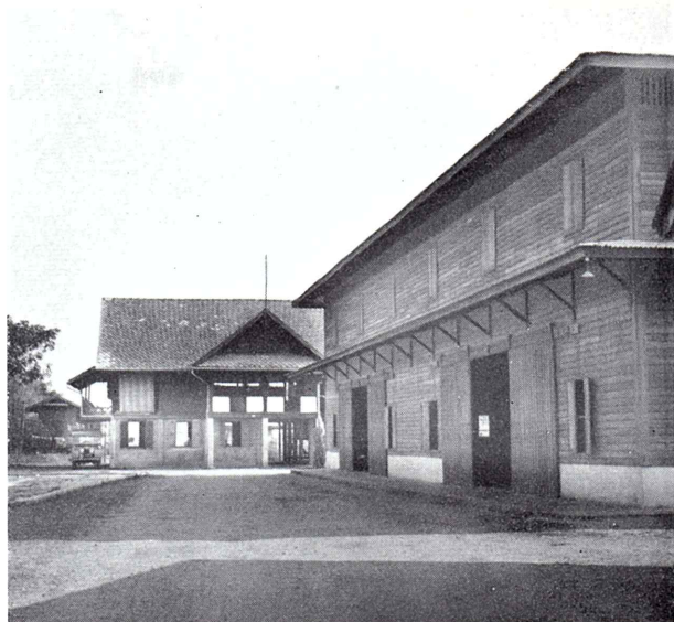
Lampang. Kontor og pakhus. I baggrunden skimtes arbejderboliger.
