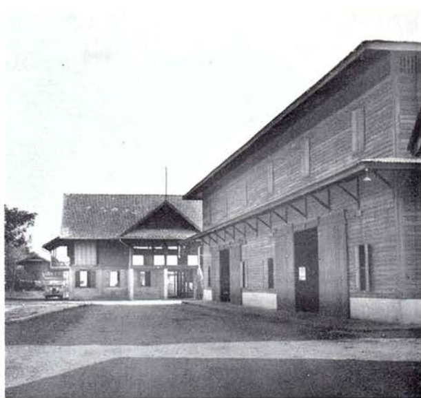
Lampang. Kontor og pakhus. I baggrunden skimtes arbejderboliger.
