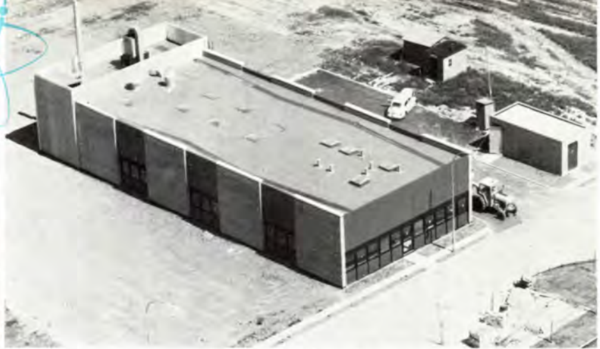
A/S Radest, Herstedøster. Den massive strålingscelle med aftræk og køletårn giver bygningen et karakteristisk udseende.
