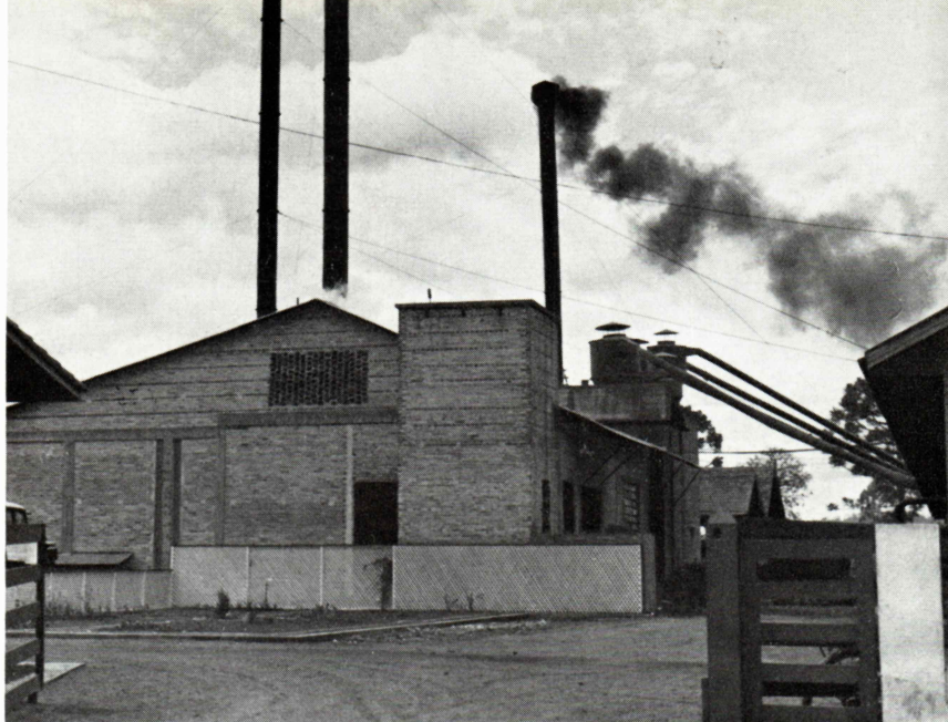
Kraftanlægget på PARANEX-fabrikken, Brasilien. PARANEX, Brazil. Power Plant.
