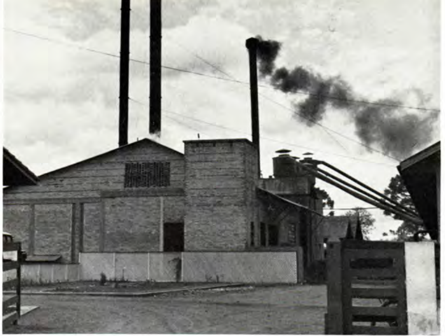
Kraftanlægget på PARANEX-fabrikken, Brasilien. PARANEX, Brazil. Power Plant.
