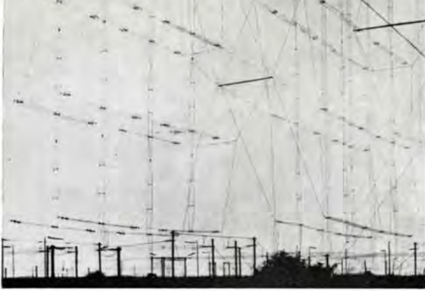
Marconi afskærmningsnet til radio- og fjernsynssender, Ghana. Marconi curtain array for radio and television transmission, Ghana.
