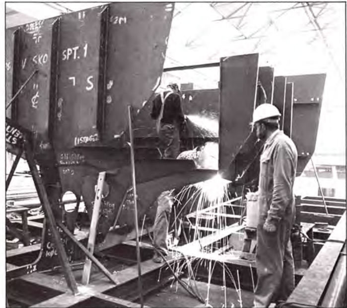
Billedet øverst t.v. viser tilpasning af klædningsplader. På fotoet herover opbygges skroget.
