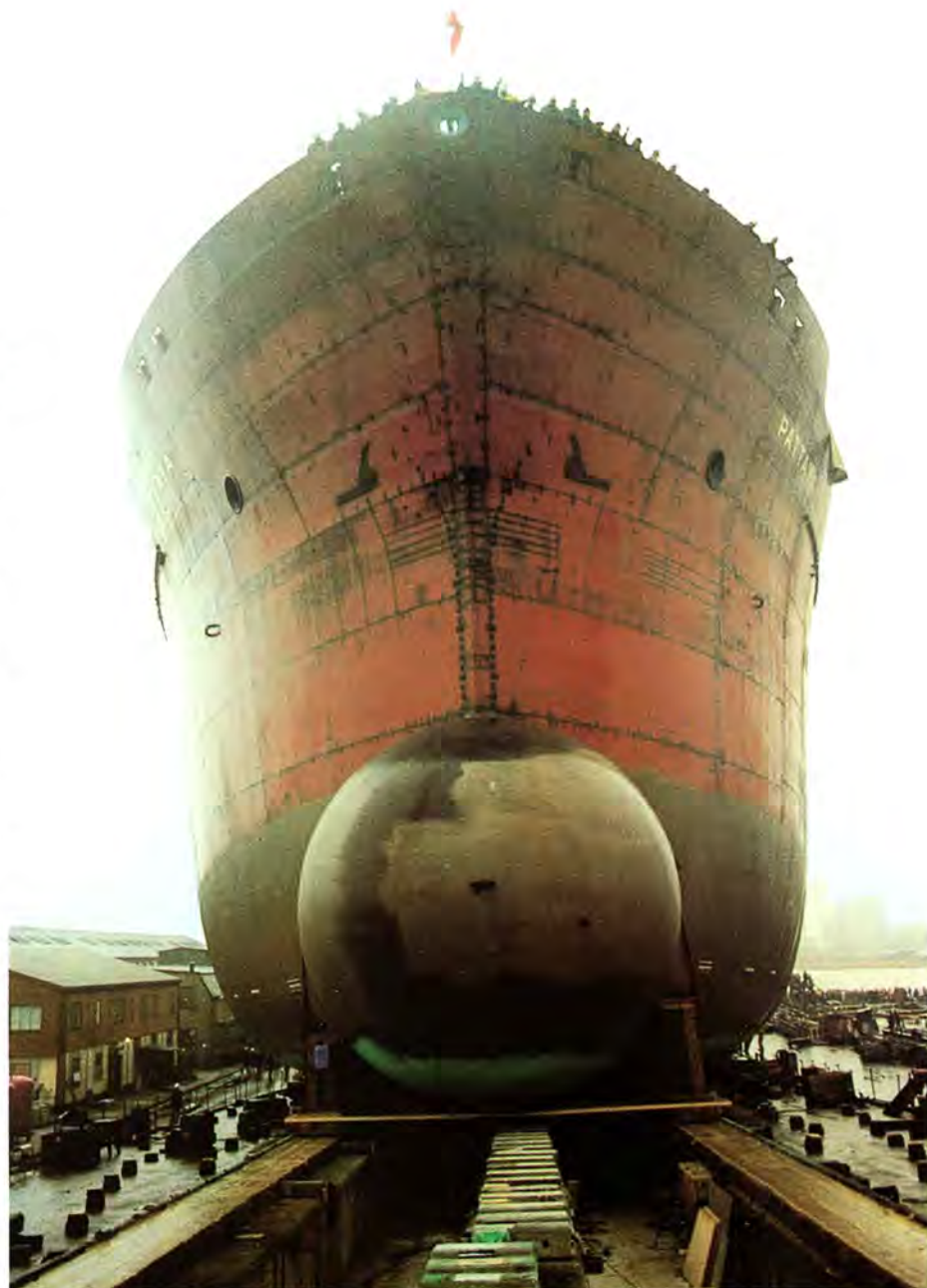
Nybygning nr. 226 før søsætningen i Nakskov.
