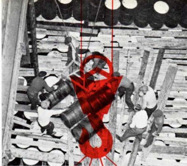
Olie i tønder. Billedet viser tydeligt brugen af dunnage træ. Oil in drums. The picture clearly shows the use of dunnage wood.
