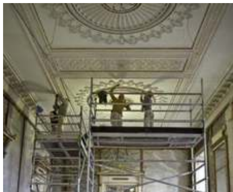
De smukke stuklofter under restaureringen
